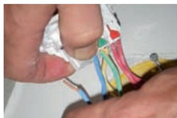
⑦ Repositionner les fils dans la nouvelle prise (prises NF)
